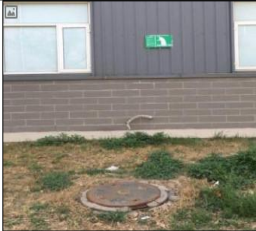
1#污水排口标识（8#厂房外东侧）
