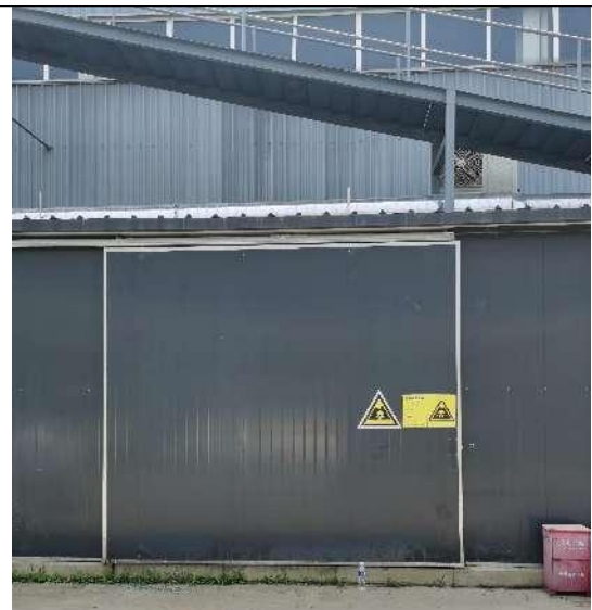
4#厂房外危险废物暂存间
