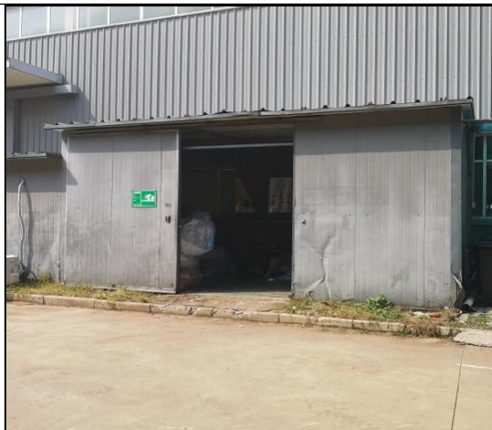
一般工业固废暂存场所
