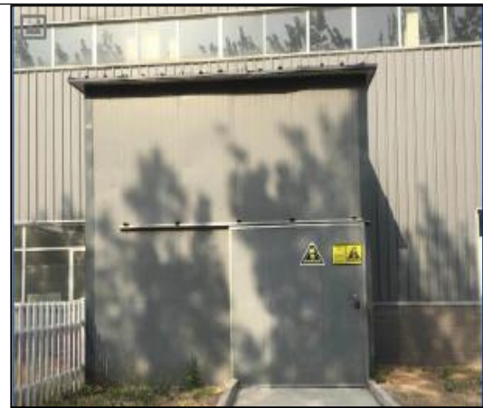
8#厂房外危险废物暂存间
